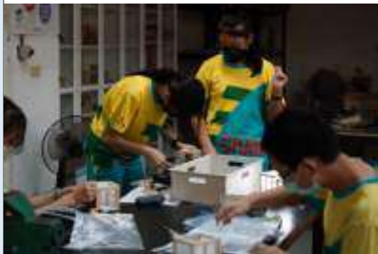
檢查燈光控制設備
