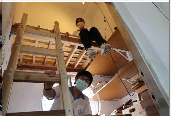
第二組-工作梯、第三組格柵層板
